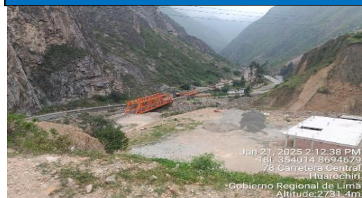
Figura N° 1. Se observa tramo crítico del sector Tambo de Viso, en la margen derecha del Río Rimac, el puente y la carretera que no cuenta con una protección adecuada para caudales de maximas avenidas.
